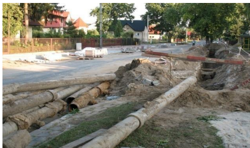
Zdjęcie 9 Rury azbestowo – cementowe
