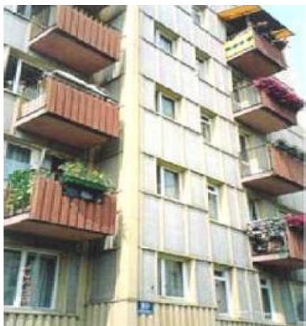
Zdjęcie 10 Elewacja wykonana z płyt azbestowo-cementowych płaskich
