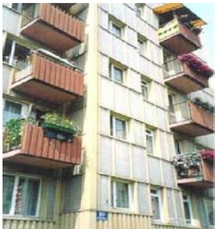
Zdjęcie 10 Elewacja wykonana z płyt azbestowo-cementowych płaskich
